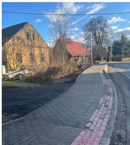
Nově vybudovaný chodník.
